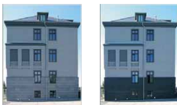
Grezzo v praxi: kamenný sokl před nátěrem a po nátěru
